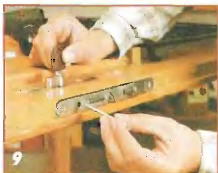
9 Профильный запорный цилиндр крепят винтом через отверстие в передней пластине замка.
