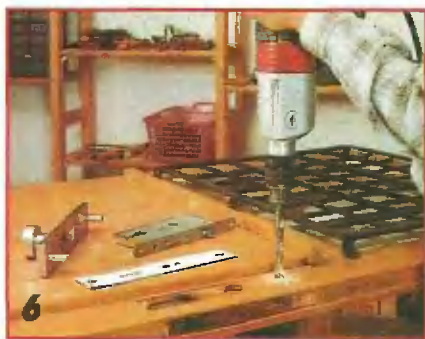
6 Ориентируясь на метки, сверлят отверстия под крепежные шурупы. Замок подбирают, как правило, по заранее известным размерам.
