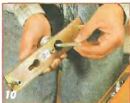
10 Прежде чем монтировать дверные накладки, необходимо установить четырехгранник в неподвижную круглую дверную ручку.
