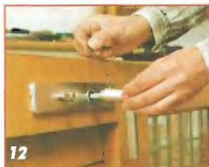
12 В заключение нажимную ручку двери надевают на четырехгранник и фиксируют ее винтом.
