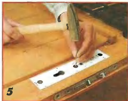
5 Отверстия для оси ручки и запирающего цилиндра размечают на двери, пользуясь бумажным шаблоном.
